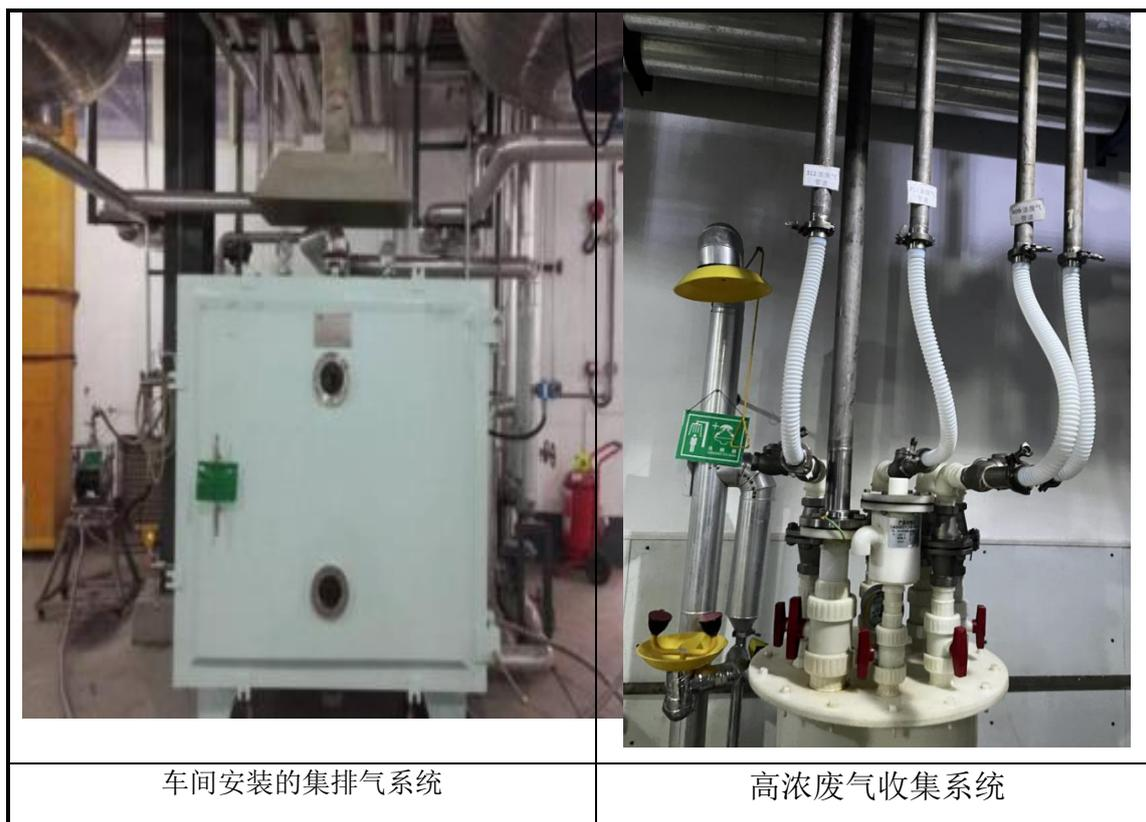
图 7.2-2 现有工程的废气污染防治设施图
