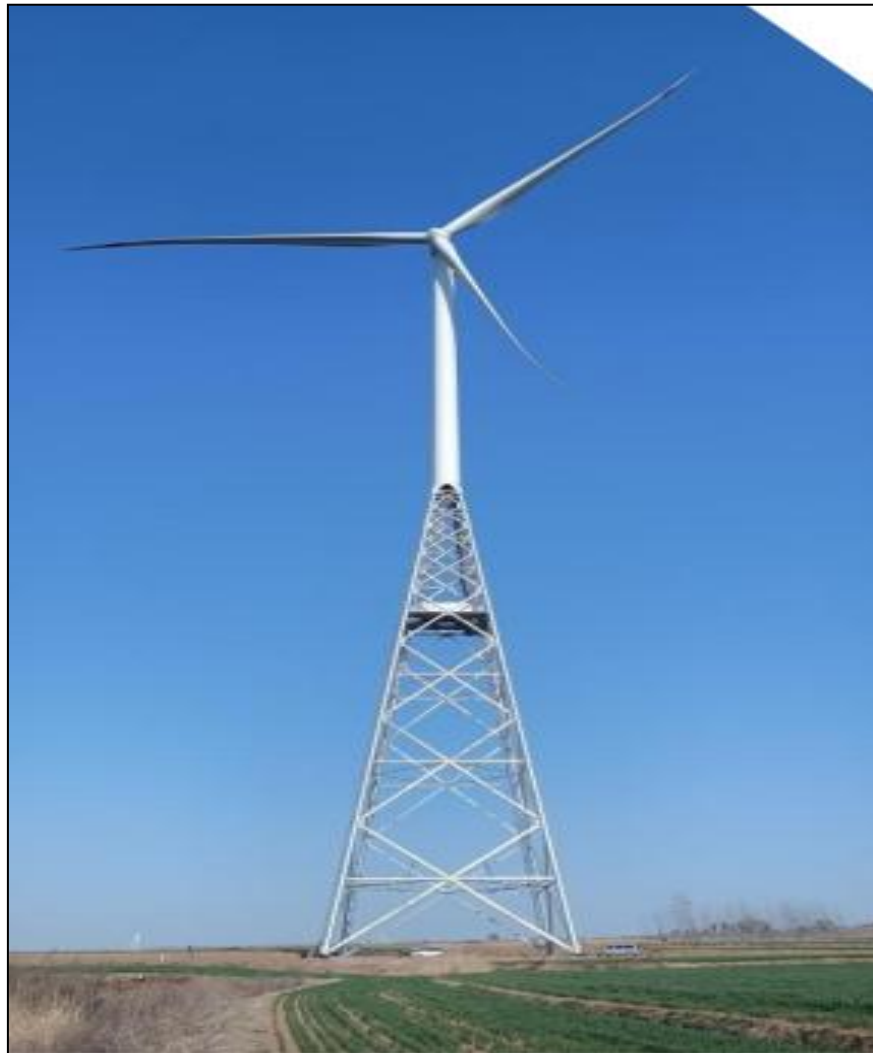
图2-1 预应力钢管桁架塔
