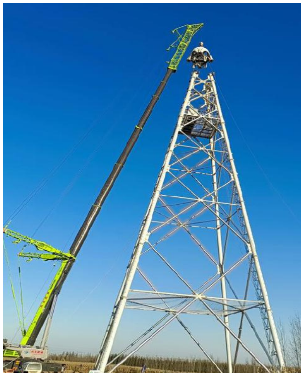
图2-4 过渡段的吊装安装示意图
