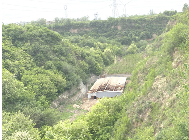
4) 现有生活垃圾渗滤液收集池
