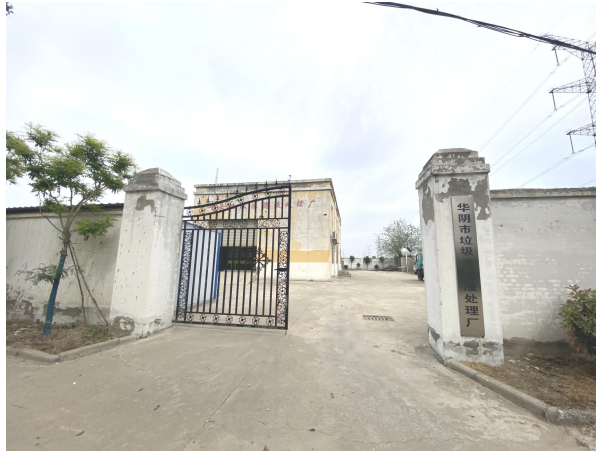
5) 现有生活垃圾渗滤液处理站
